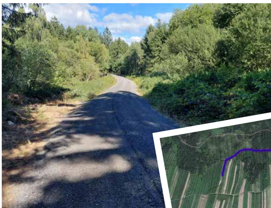
In Altweitra wurde der sogenannte „Eberhartsweg“ saniert. Dafür wurde Fräs-material, welches bei der Sanierung der B41 im Bereich der Ortsdurchfahrt Altweitra und des Wallers angefallen ist, am Weg aufgebracht. Noch im Herbst wird der Weg gegrädert und gewalzt.
